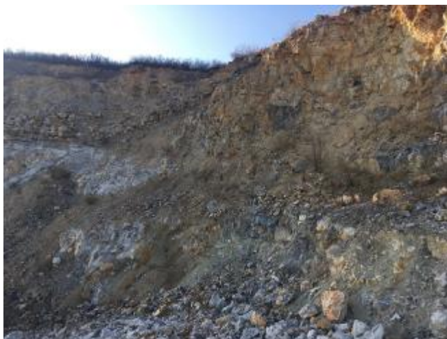
照片 3-1 崩塌隐患 BY1 (镜向 SE)
